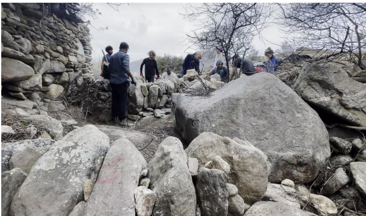
Εικόνα 9 και 10: Εργασίες ενίσχυσης κοιλοτήτων κατά μήκος ρεμάτων με λίθινες κατασκευές (μικροφράγματα) για καλύτερη διαχείριση του νερού.
